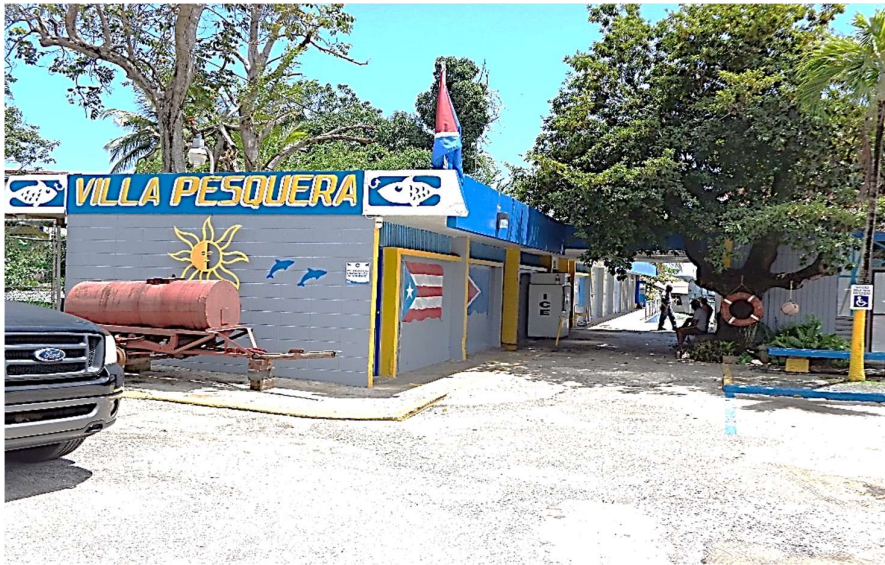
Entrada de la Villa Pesquera Puerto Real
